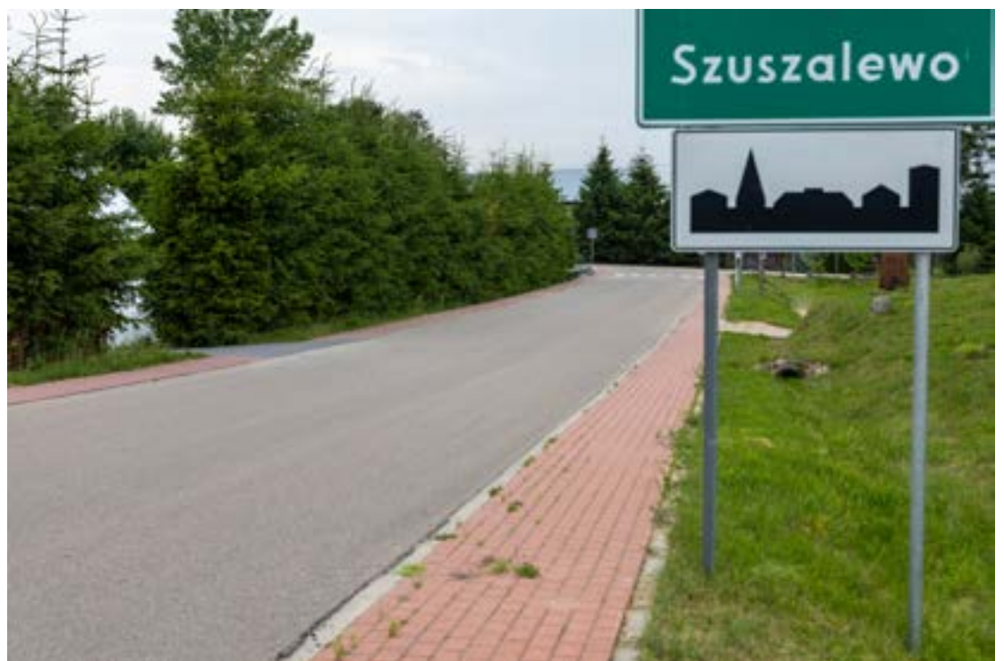
Wyremontowana droga w Szuszałewie
