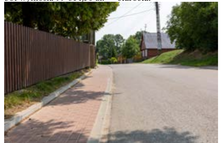
Pobocze utwardzone kostką betonową, ul. Małyszówka
