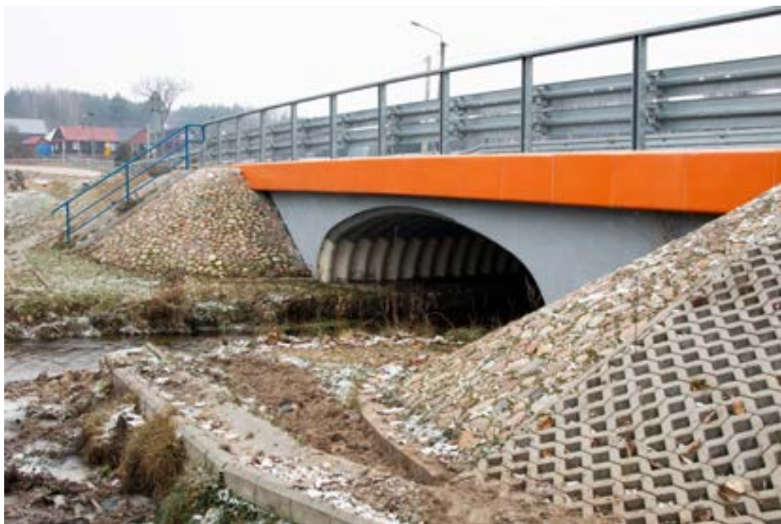
Przebudowany dzięki Powiatowi Sokólskiemu most na Sokółdzie w okolicach miejscowości Żuki
